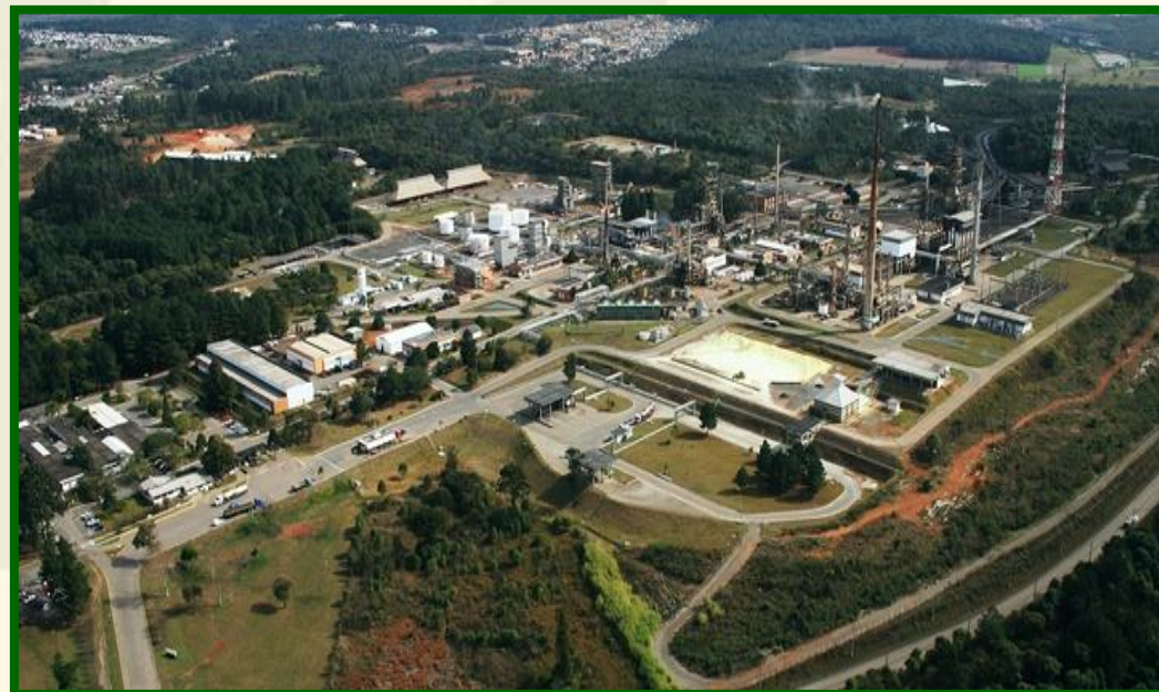
Visão aérea das instalações
