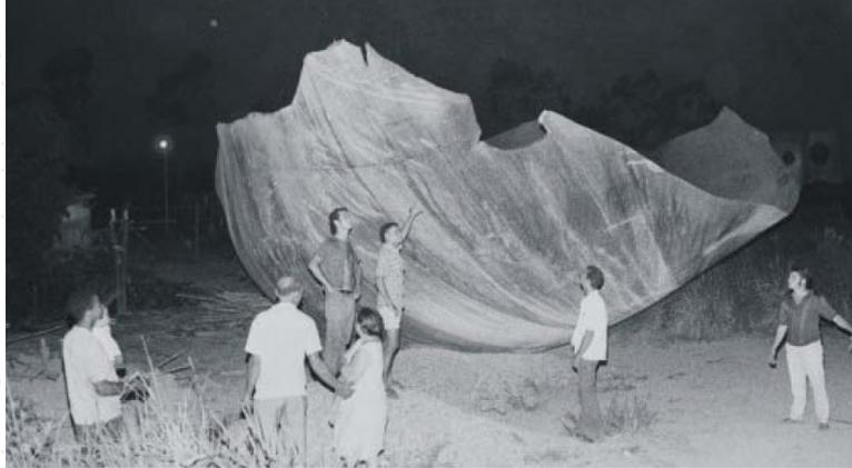
*O incêndio que atingiu a REDUC em 31/03/1972 ficou conhecido como "o fim do mundo". A explosão de três tanques esferas de gás liquefeito de petróleo (GLP) deixou 42 trabalhadores mortos e 40 feridos. O pedaço de um deles foi encontrado a 1km de distância da Refinaria.*
