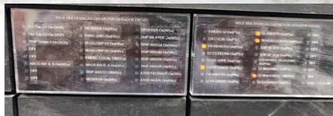
Uma das imagens no Relatório do GT NR-13, de 2018, mostra um frontal de um relé de proteção de gerador a diesel com poucos LEDs configurados para atuação de proteções elétricas, dificultando o serviço de identificação de falha.
